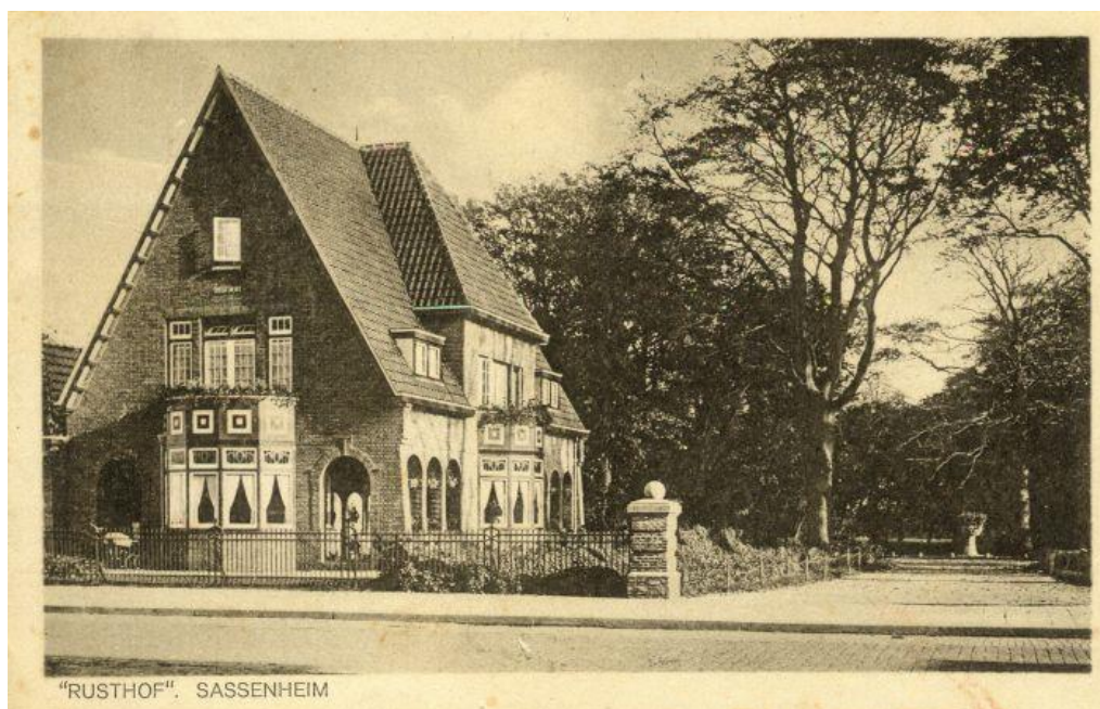
Villa Rusthoff. Het muurtje aan de straat is vervangen door een hek van de villa. Een stenen vaas met bloemen staat in de as van het toegangspad (SOS F02885)
